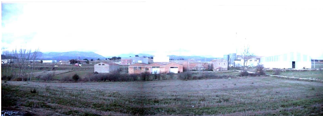
Vista general dels darreres de les naus i magatzems existents en sòl rústec en la zona llevant del sector.
