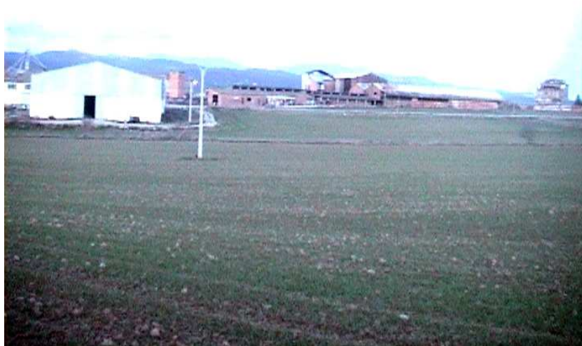
Terrenys del sector a llevant amb la bòbila a l'altre banda de la C-1410 en segon terme. En primer terme nau existents en sol rústic.
